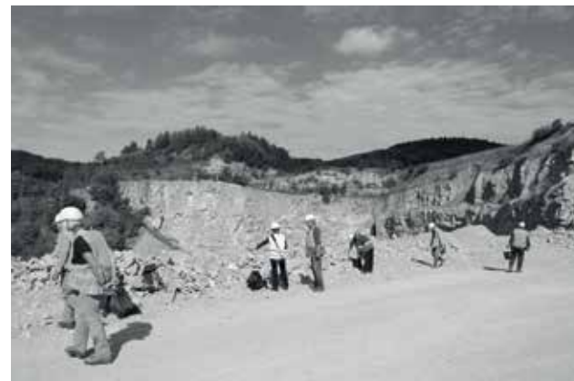
Der Bruch zeigt bereits beeindruckende Dimensionen
